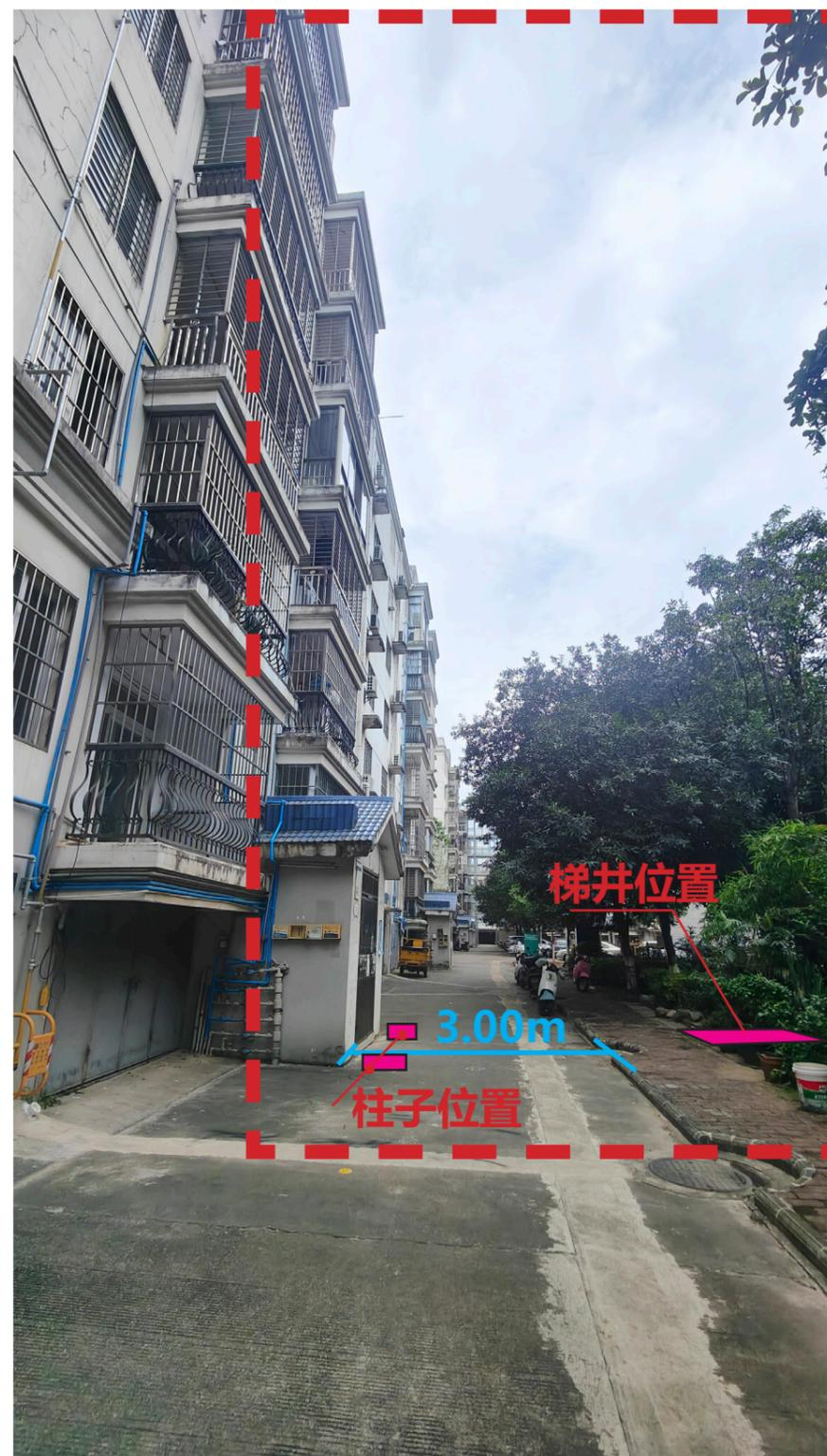
根据现场勘查，加装电梯梯井及连廊柱子均避开了现有的管线及检查井所在位置，加装电梯不会对小区现有的管线及用水用电、燃气等造成影响。
