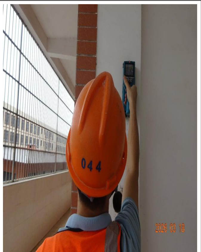
柱钢筋配置检测
