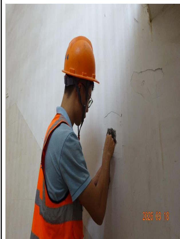
梁钢筋配置检测
