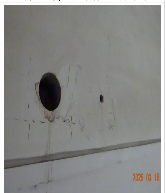
一层梁F-3600×7~8 轴, 混凝土强度 (钻芯法) 检测
