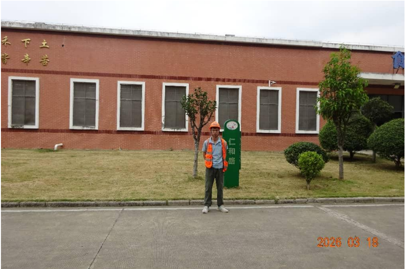
图 1-1 建筑外立面图
