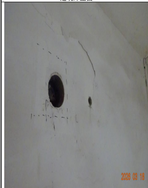
一层梁 7×E~F轴, 混凝土强度 (钻芯法) 检测
