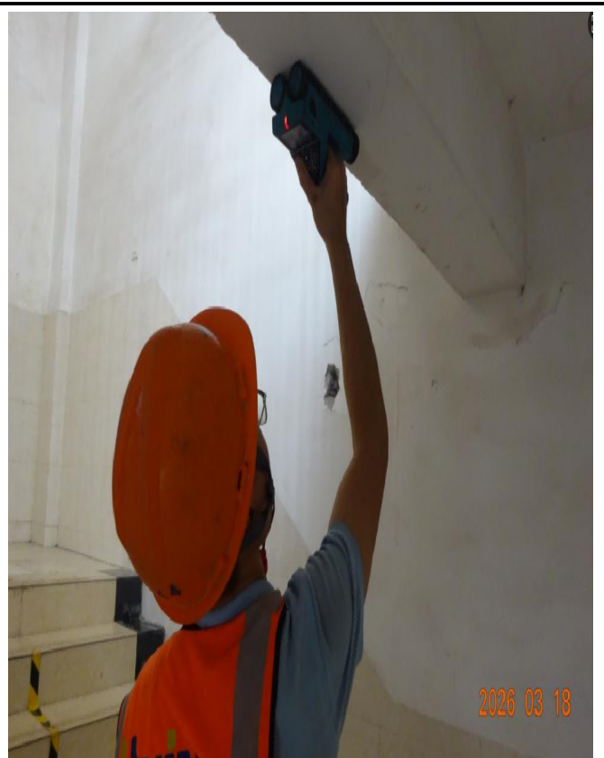
梁钢筋配置检测
