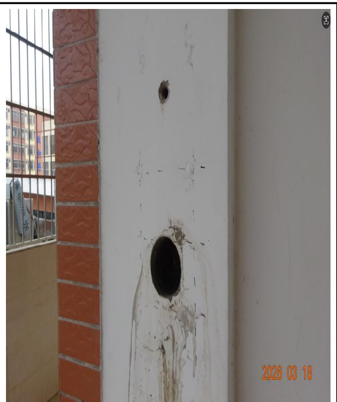
二层柱 7×E轴, 混凝土强度 (钻芯法) 检测
