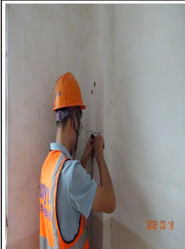
柱钢筋配置检测
