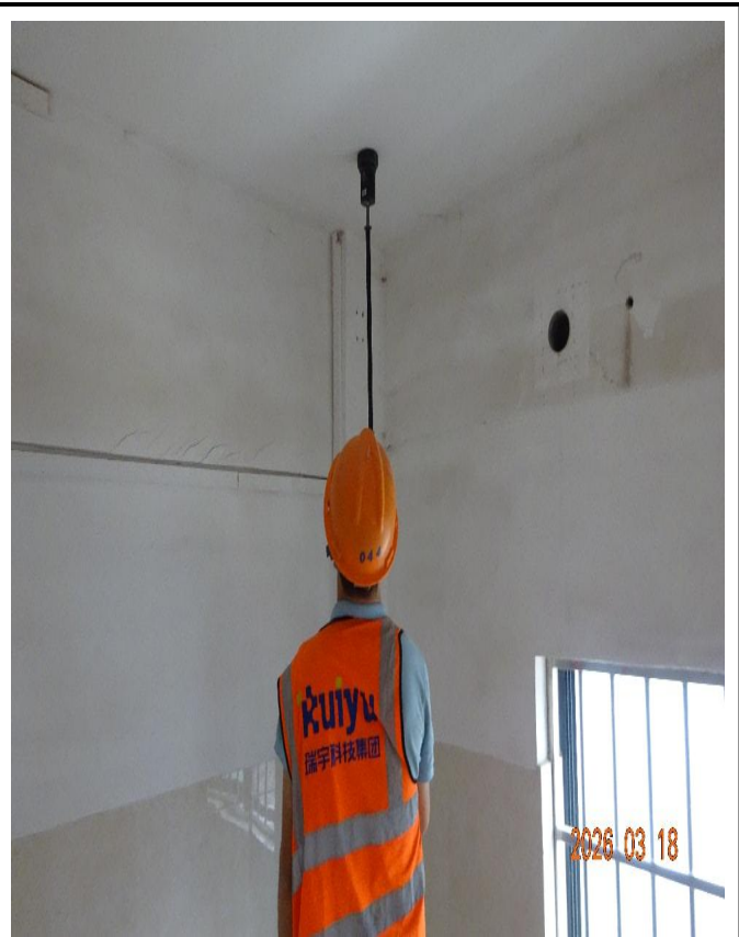
楼板厚度检测
