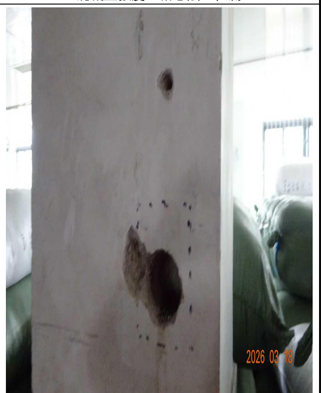
一层柱 3×E轴, 混凝土强度 (钻芯法) 检测
