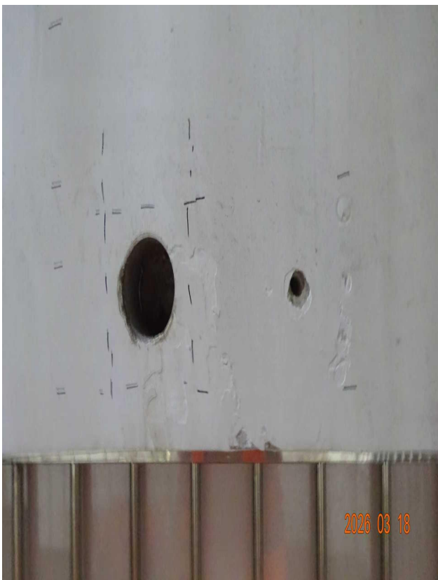
一层梁 4×B~C轴, 混凝土强度 (钻芯法) 检测
