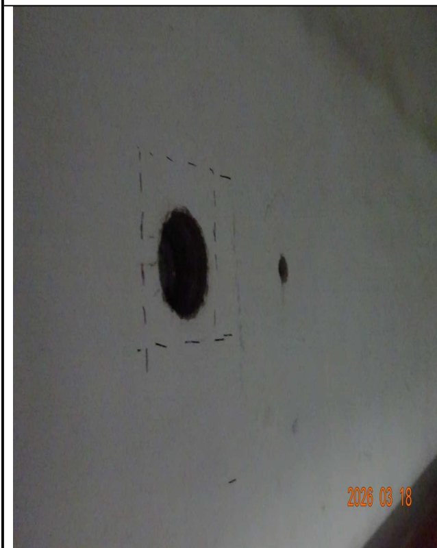
一层梁 5×B~C轴, 混凝土强度 (钻芯法) 检测
