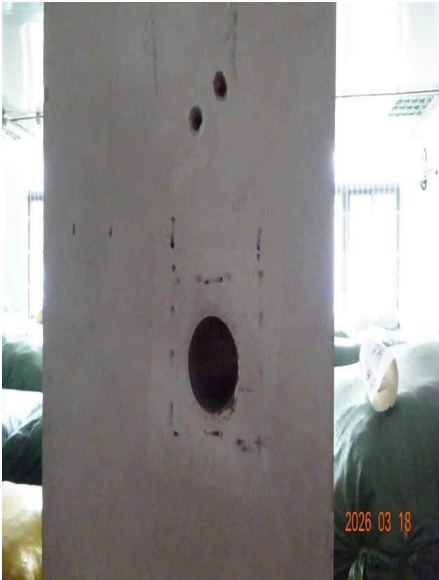
一层柱 4×E轴, 混凝土强度 (钻芯法) 检测
