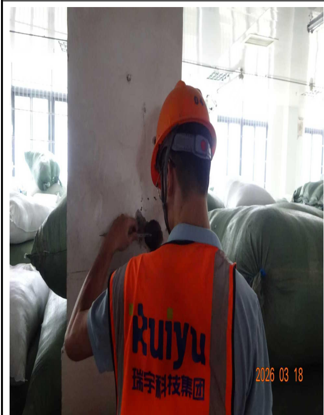
柱钢筋配置检测
