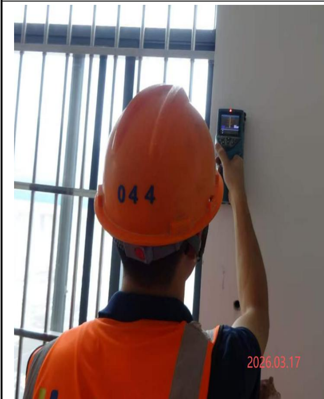
柱钢筋配置检测
