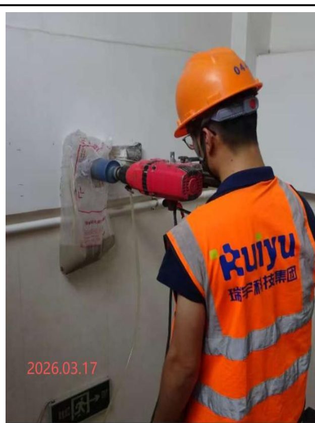
混凝土强度 (钻芯法) 检测
