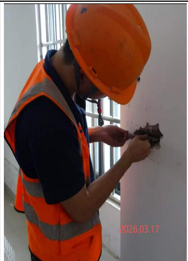
柱钢筋配置检测
