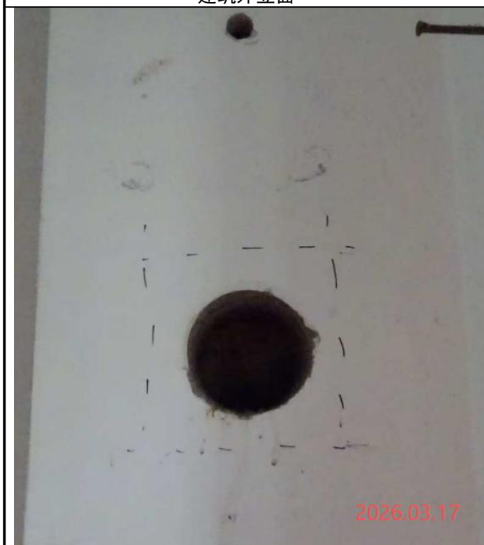
二层梁 4×E~F轴, 混凝土强度 (钻芯法) 检测
