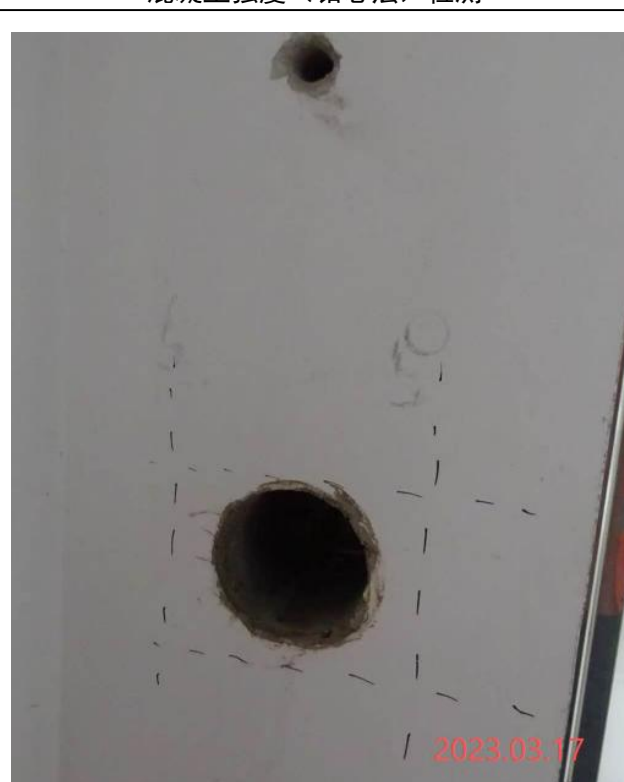
一层柱 4×F轴, 混凝土强度 (钻芯法) 检测
