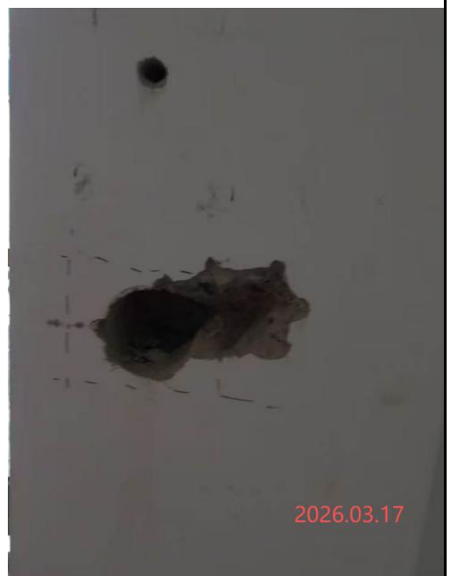
一层梁F×1~4轴, 混凝土强度(钻芯法)检测
