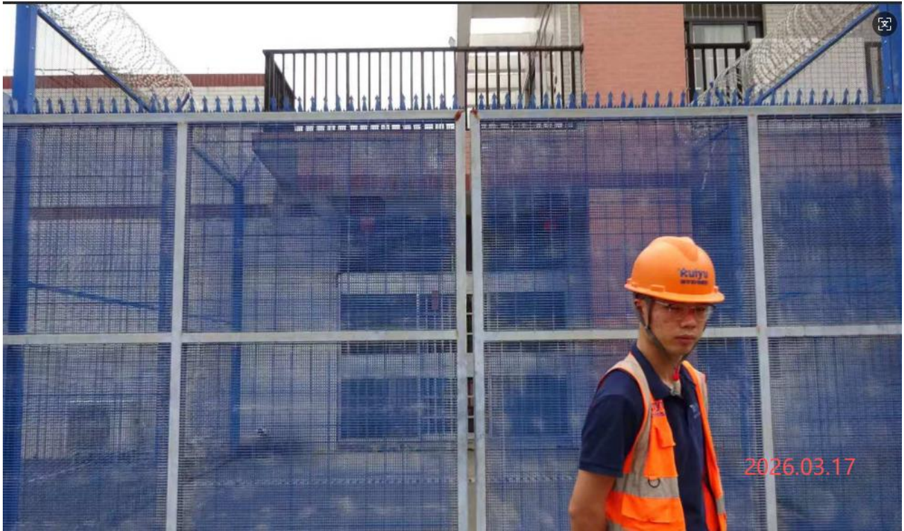
图 1-1 建筑外立面图
