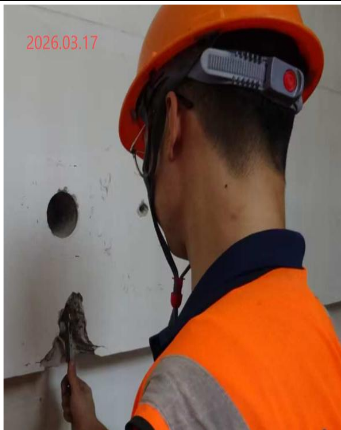
梁钢筋配置检测
