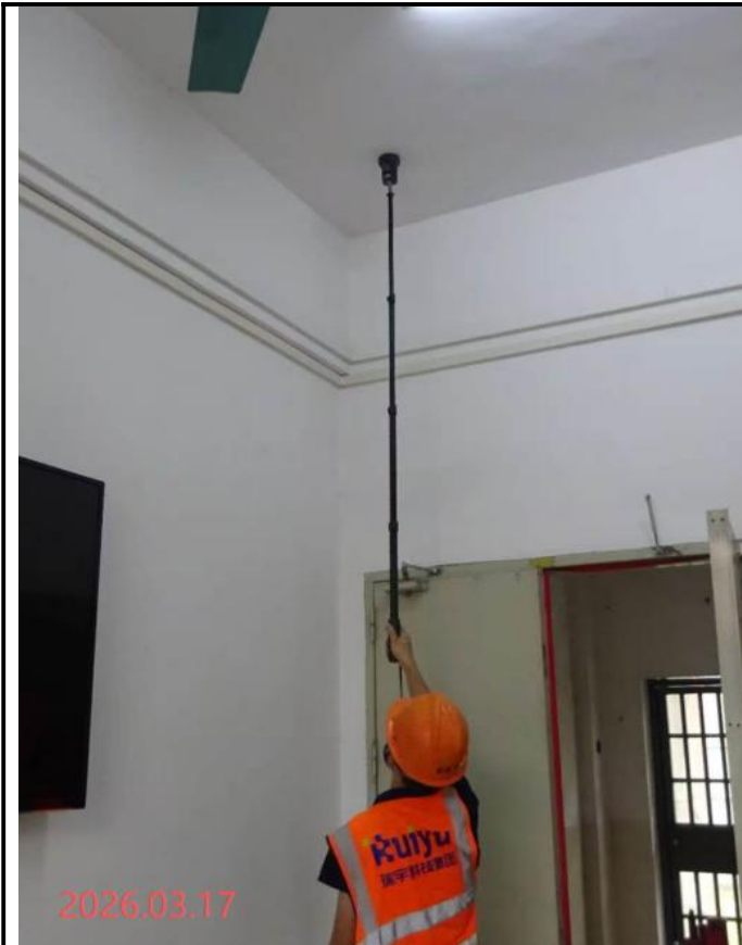
楼板厚度检测
