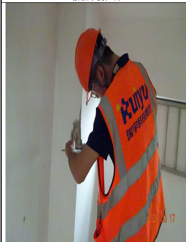
柱钢筋配置检测
