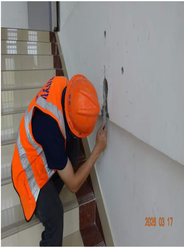
梁钢筋配置检测
