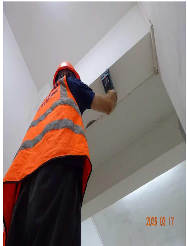
梁钢筋配置检测
