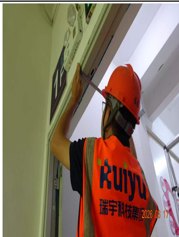
墙体厚度测量
