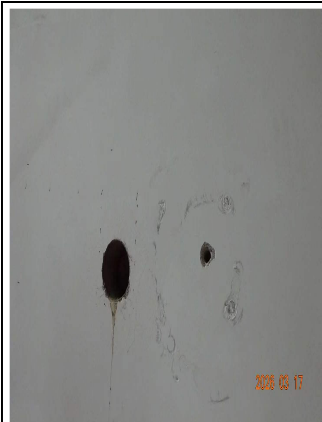
一层梁E×1~4轴, 混凝土强度(钻芯法)检测
