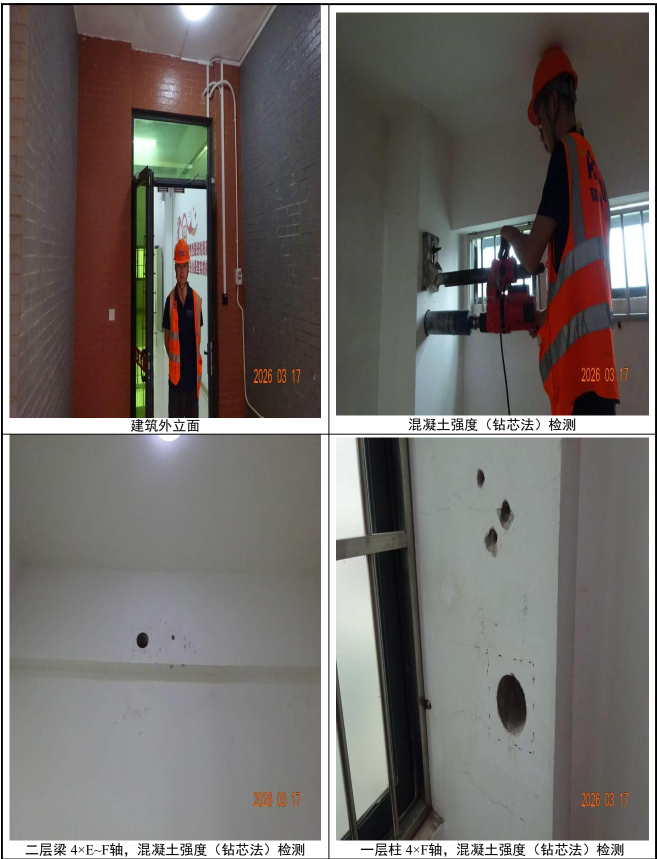
附图 4: 建筑外立面及现场检测照片
