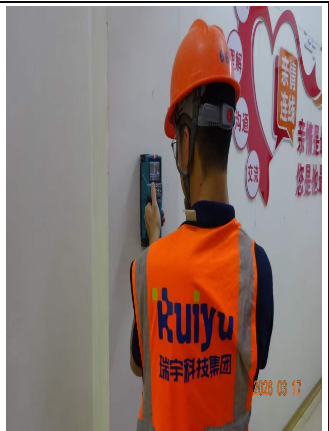
柱钢筋配置检测
