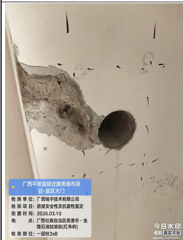
一层柱3×B轴, 混凝土强度(钻芯法)检测
