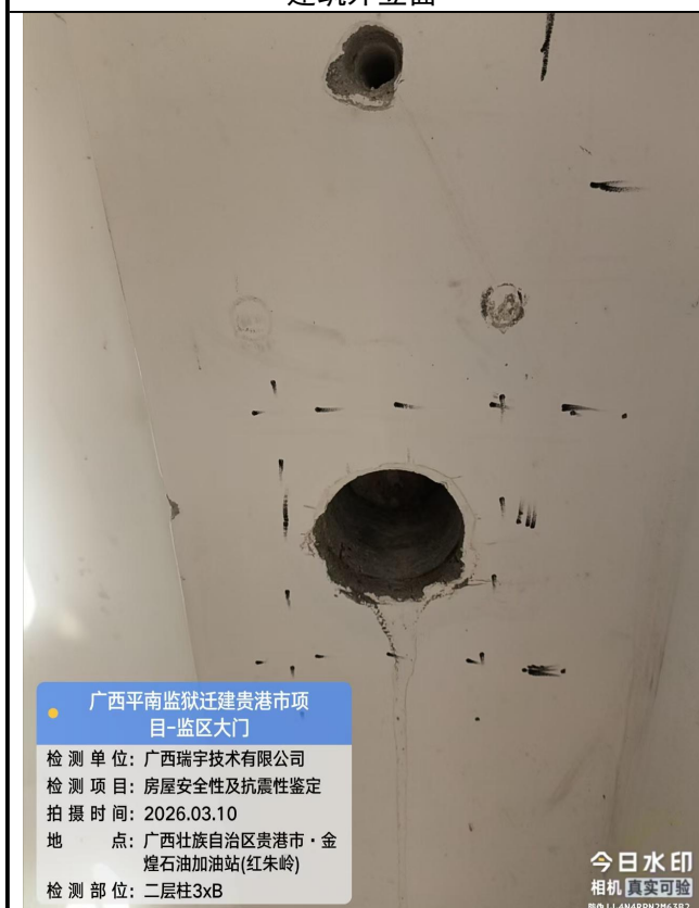
二层柱 3xB轴, 混凝土强度(钻芯法)检测
