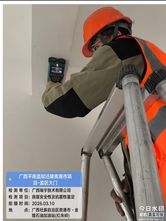
梁钢筋配置检测
