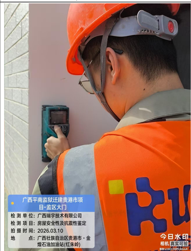
柱钢筋配置检测
