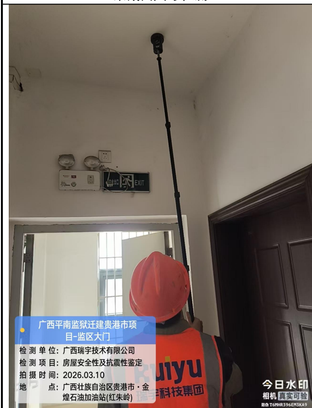
楼板厚度检测
