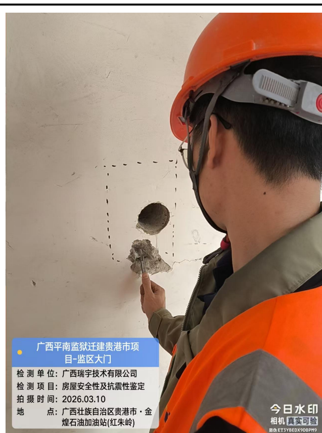
梁钢筋配置检测
