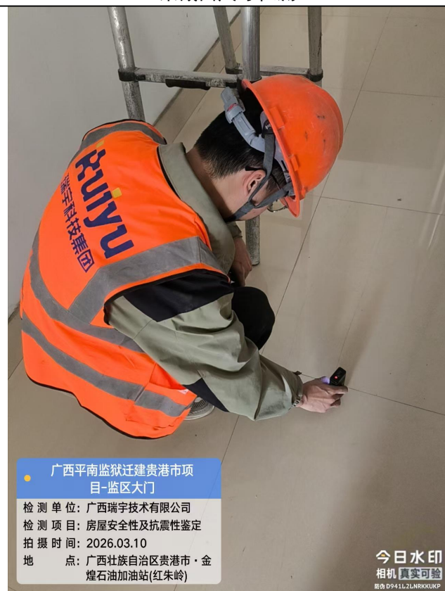
楼层层高检测
