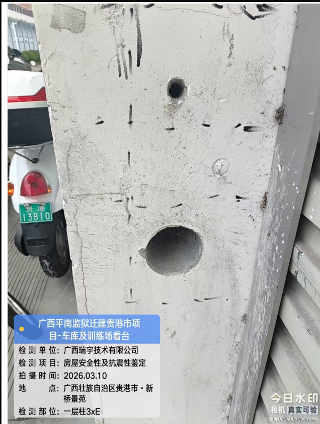
一层柱 3xE轴, 混凝土强度 (钻芯法) 检测
