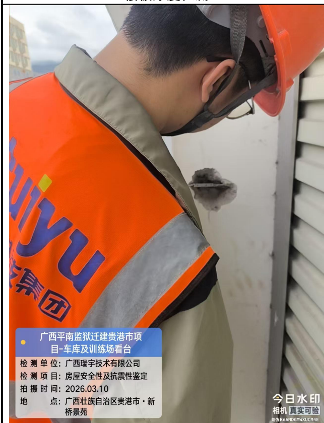
柱钢筋配置检测
