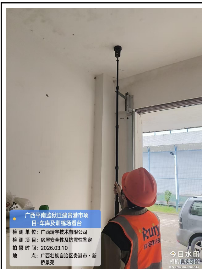
楼板厚度检测
