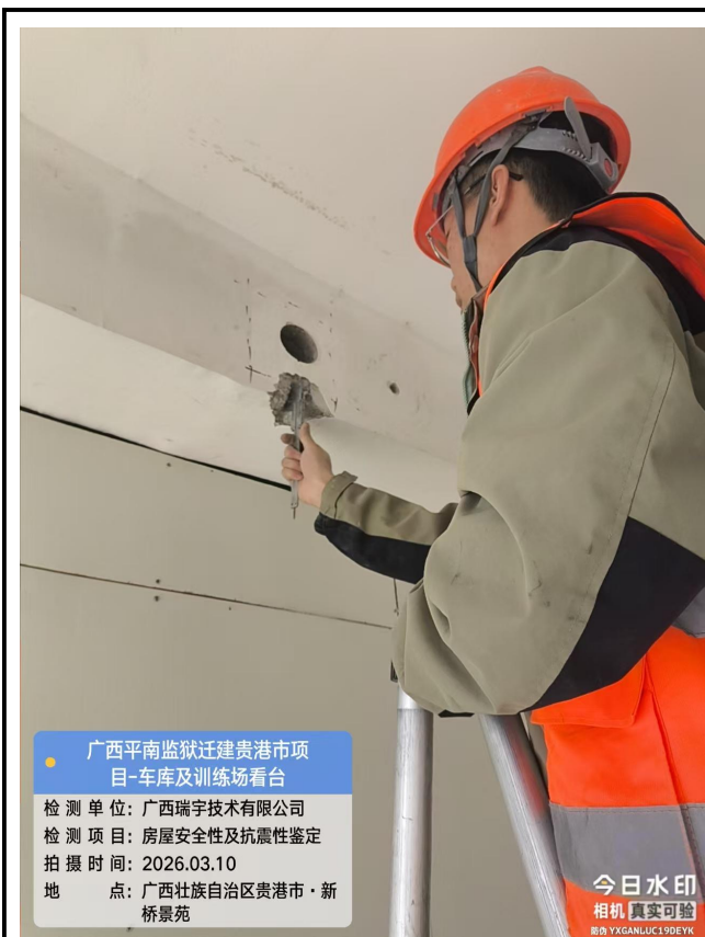
梁钢筋配置检测
