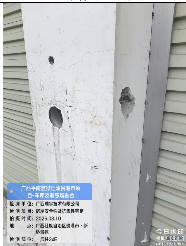
一层柱 2×E轴, 混凝土强度(钻芯法)检测
