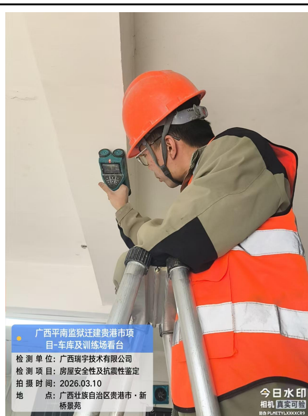
梁钢筋配置检测
