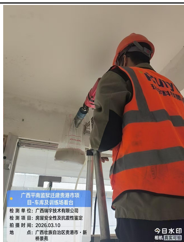
混凝土强度(钻芯法)检测
