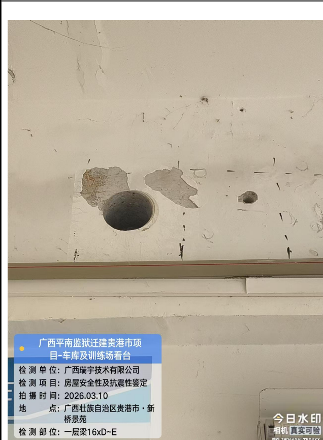
一层梁 16xD~E轴, 混凝土强度 (钻芯法) 检测
