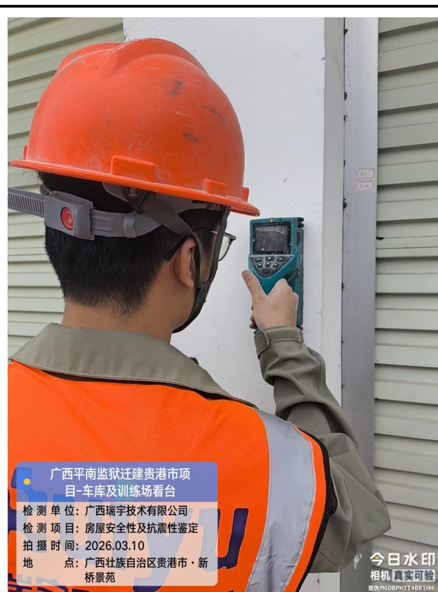
柱钢筋配置检测
