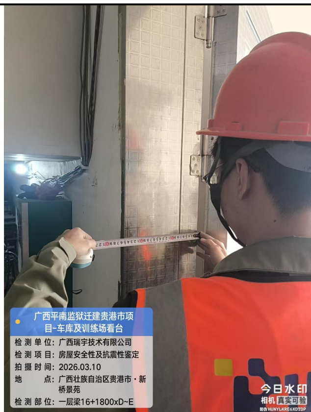
墙体厚度测量
