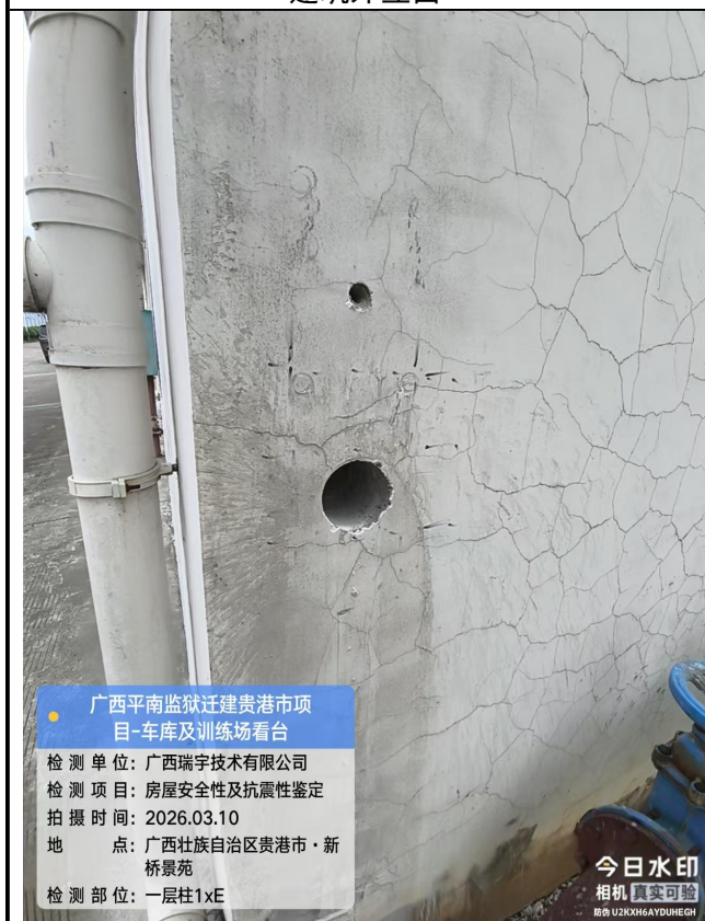
一层柱 1×E轴, 混凝土强度(钻芯法)检测
