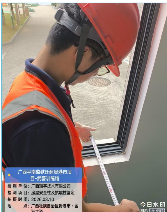
墙体厚度测量
