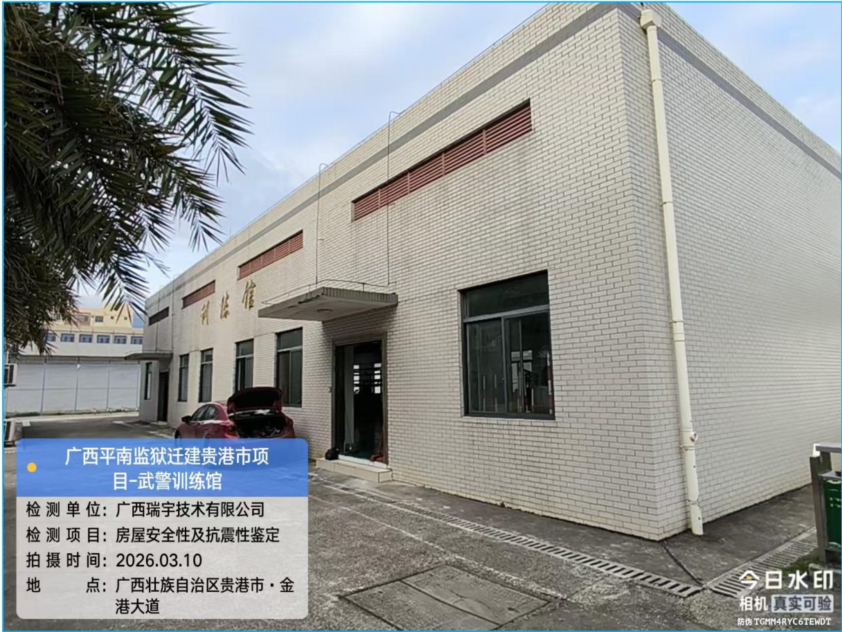
图 1-1 建筑外立面图
