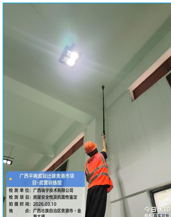
楼板厚度测量
