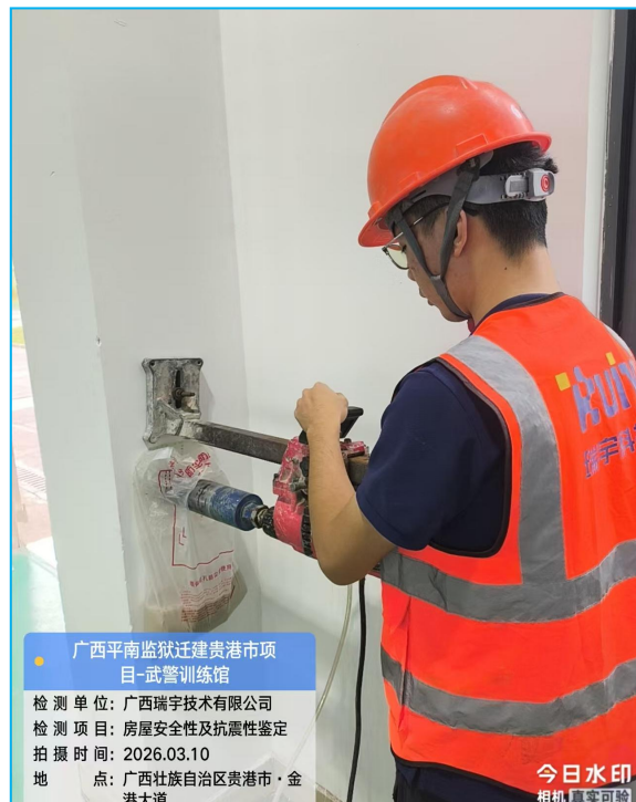
混凝土强度(钻心法)检测
