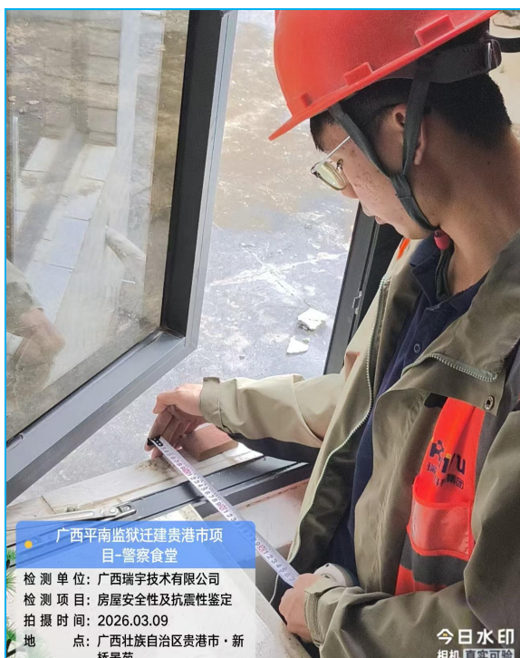
墙体厚度测量
