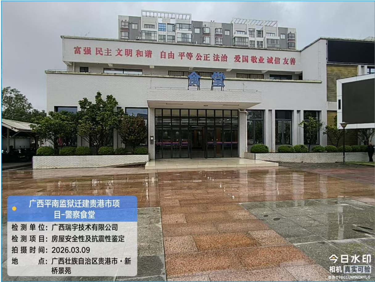
图 1-1 建筑外立面图
