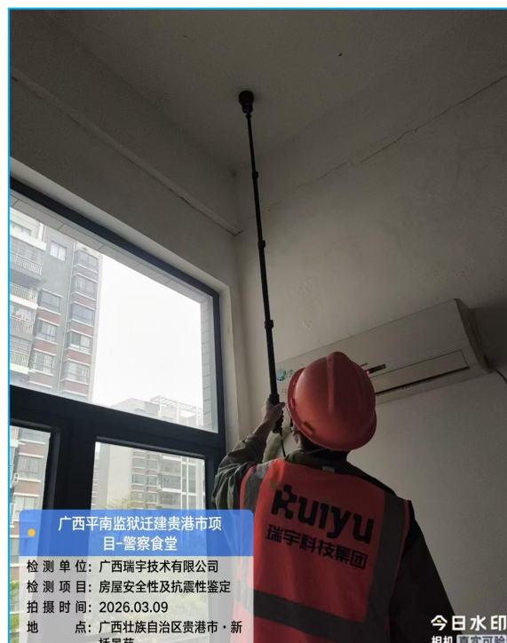
楼板厚度测量
