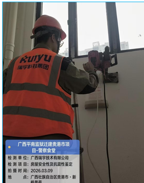
混凝土强度(钻心法)检测
