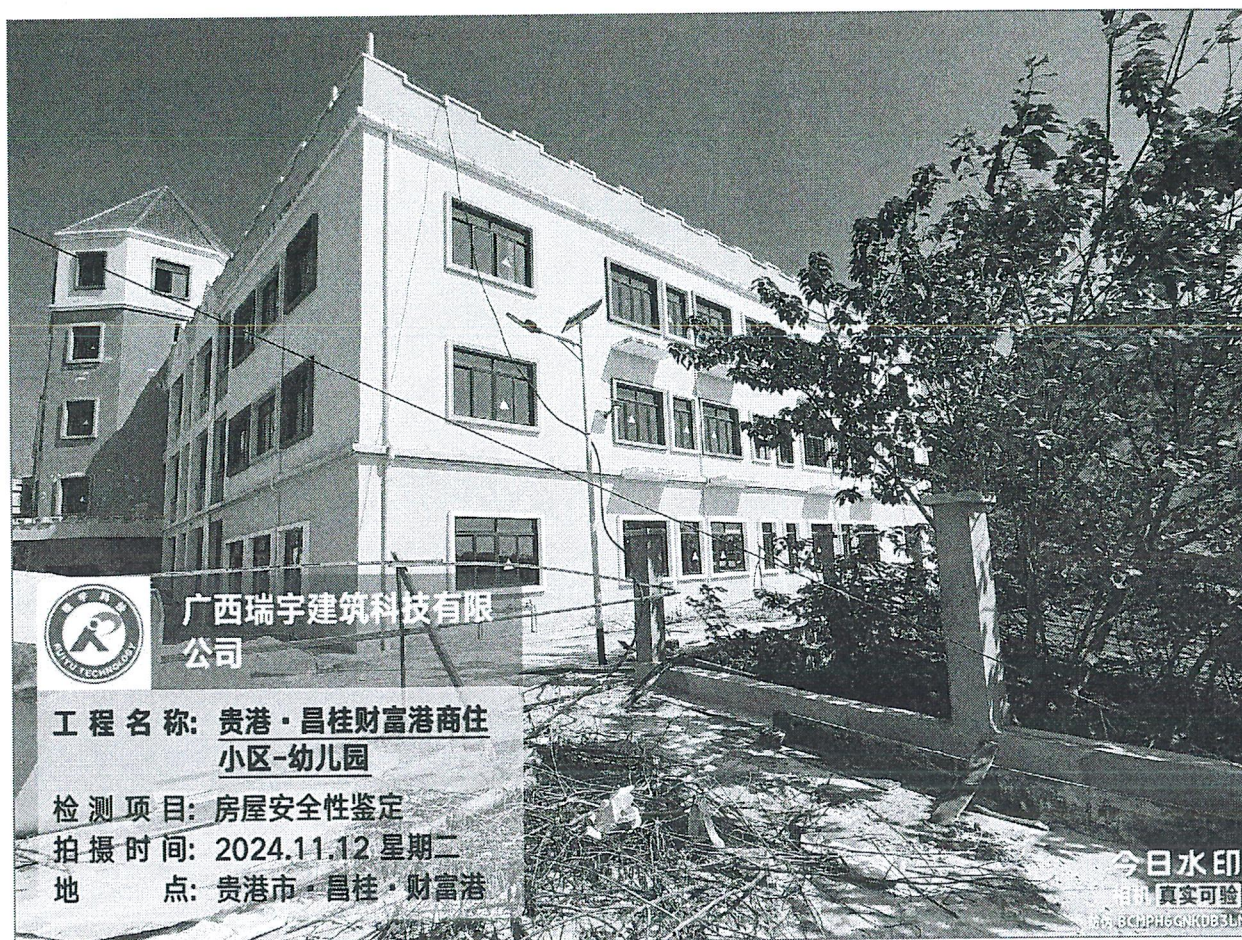
图 1-1 建筑外立面图
