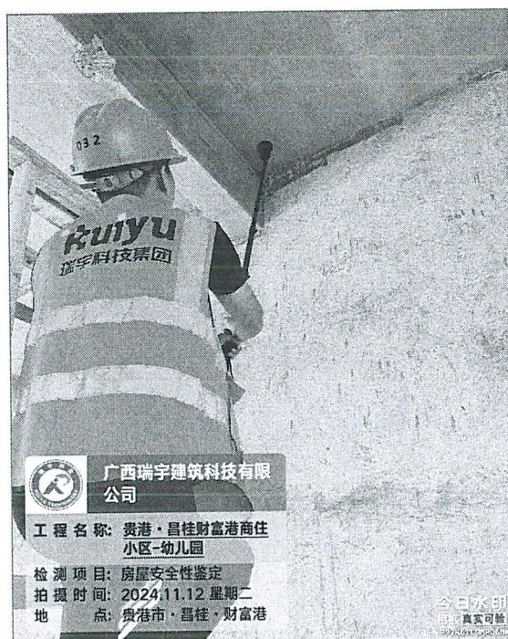
楼板厚度检测
