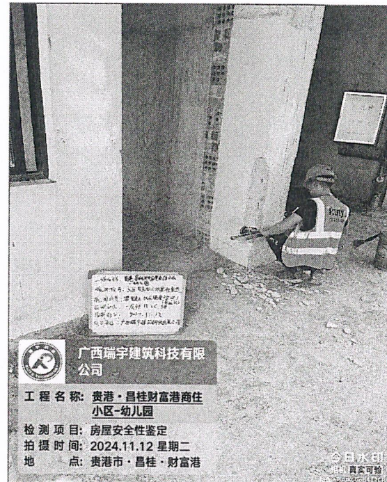
混凝土强度(剪压法)检测
